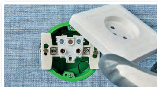
Fig. 9. Montare priză
